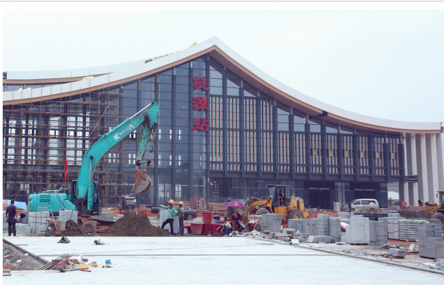
11月16日,黔张常铁路桃源站前广场正抓紧施工。黔张常铁路桃源站站前广场项目占地约20公顷,总投资约2.3亿元,配套建设长途客运站及出租车、公交车、社会车辆停车场等公共设施。 本报通讯员 鲁文 摄
