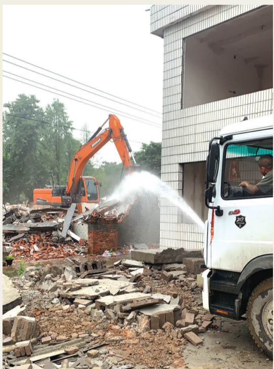
增减挂钩V地块项目(武陵区长庚街道)倒房现场
