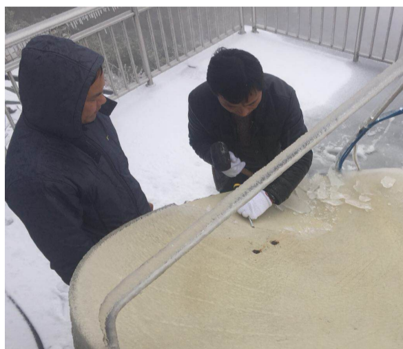
2020年春节,常德转播人顶着大雪对卫星天线进行清理维护。
