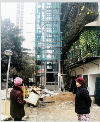
银苑新区外,居民正在观望修建中的电梯。
